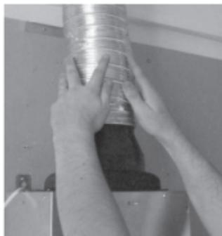
Ohyby a zahnutí hliníkové trubky snižují výkon odsávání, proto je třeba, aby byla hliníková trubka co nejméně ohnuta.
