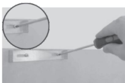
Do vyvrtaných otvorů A, B o průměru 8 mm s hmoždinkami vložte 2 šrouby 5,5 x 45. Vzdálenost mezi zdí a hlavičkou šroubu musí být 5 mm.
